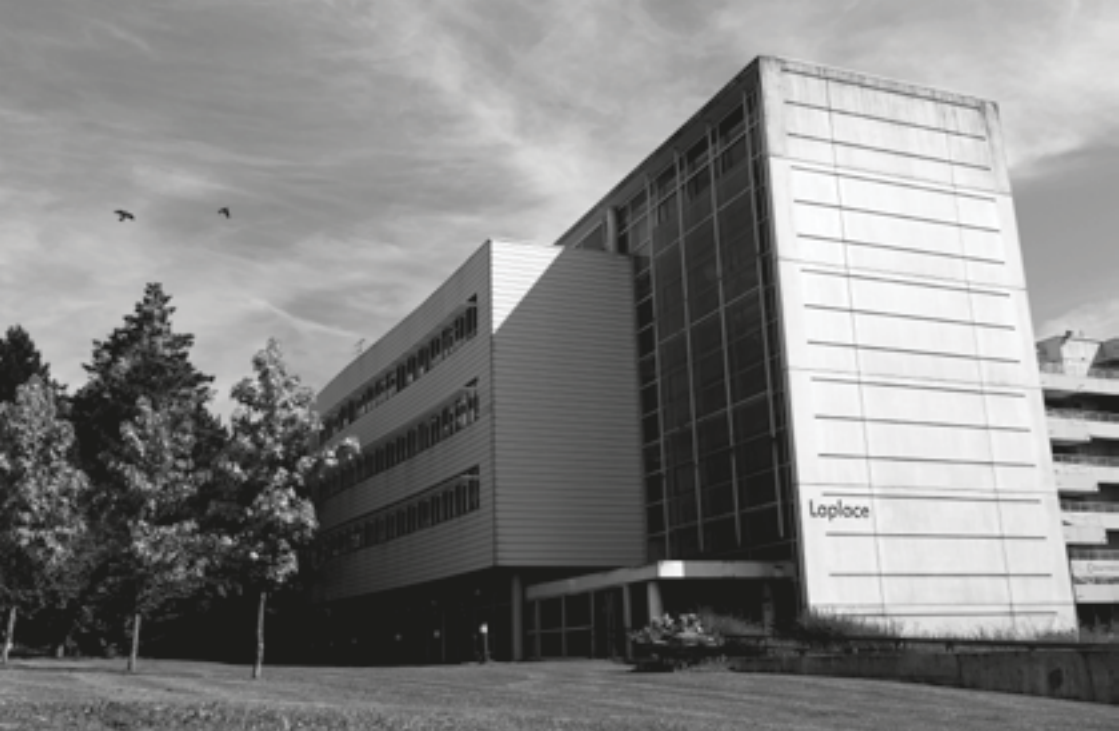
Bâtiment Laplace ENS Paris-Saclay Locaux de la MSH Paris-Saclay
